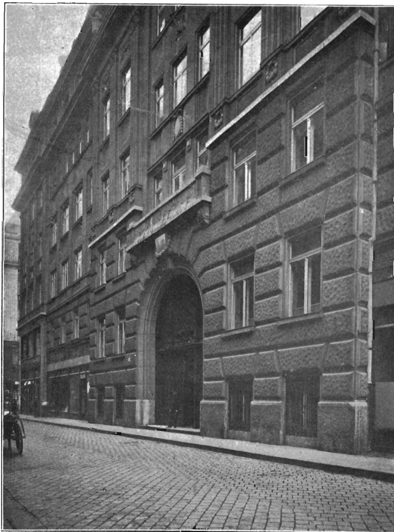
12. A főgimnázium homlokzata.
